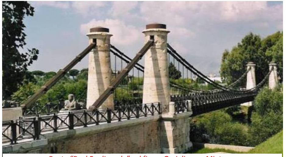
Ponte “Real Ferdinando” sul fiume Garigliano a Minturno
